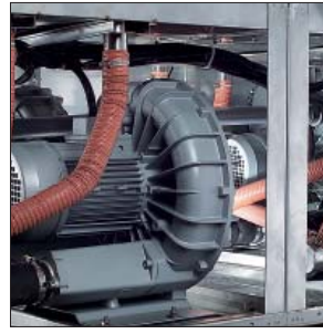
Optionale Turbo-Gebläse. Durch diese Gebläse bleibt auf der Oberfläche des Geschirrs nur ein vernachlässigbar geringer Prozentsatz an Feuchtigkeit zurück.
