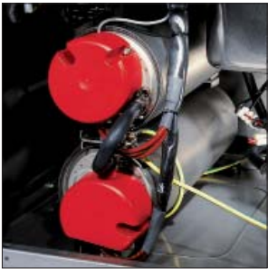
AISI 316 Edelstahlboiler, komplett isoliert, um Wärmeverluste zu minimieren.
